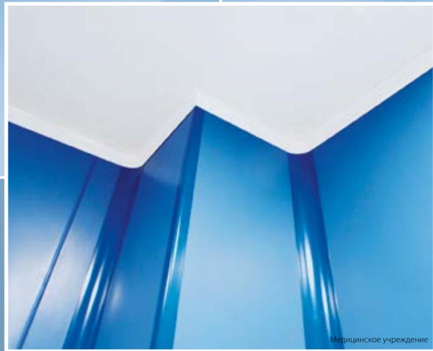
В качестве элементов обрамления используются скругляющие профили, которые идеально решают задачу минимизации острых и прямых углов, обеспечивают удобный доступ для очистки и дезинфекции.
